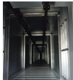
Figura 66 - Novo forno elétrico instalado na Pintura.
